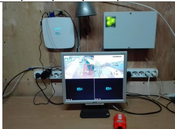
Оборудование контроля видеонаблюдения в бытовке охраны
